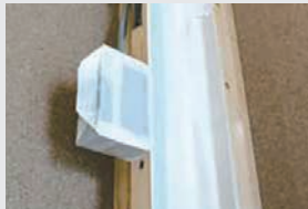
養生作業 (コンセント周り)
