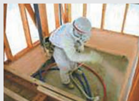
基礎部立上り
