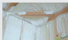
熱橋金物部分
