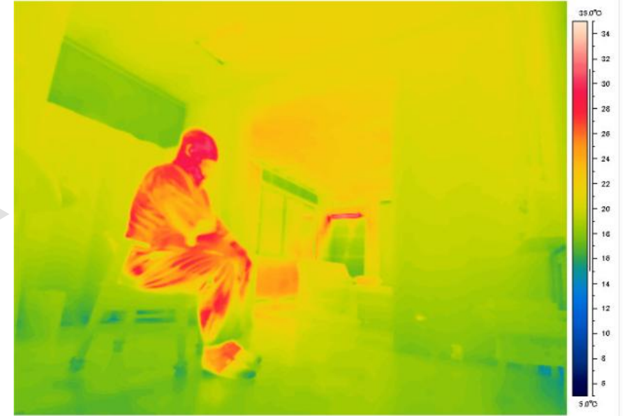
断熱+気密改修後
