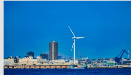
国家的重要施設
