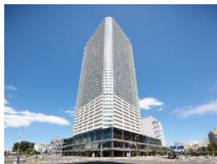
建築物部門：ONE札幌ステーションタワー
