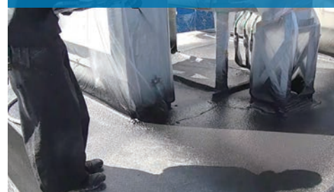
アクアモエンNEO 吹付け状況
