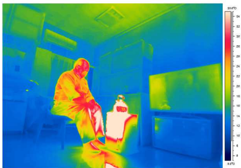
断熱+気密改修前
