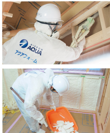
現場施工・端材発生
