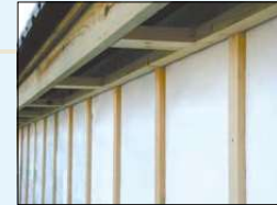
透湿防水シートの施工
