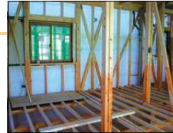
施工前の屋内
