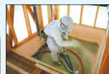
ユニット基礎部立上り
