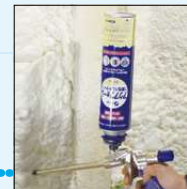
細かい隙間へ注入
