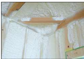
熱橋金物部分
