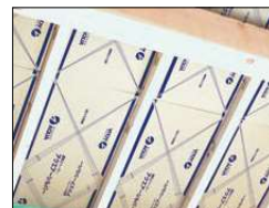
通気スぺーサーの施工
