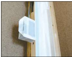
養生作業(コンセント周り)
