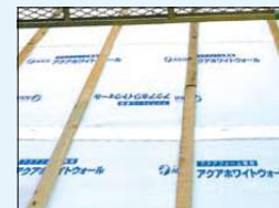
透湿防水シートの施工
