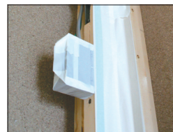
養生作業(コンセント周り)
