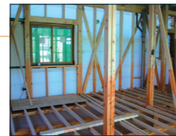
施工前の屋内
