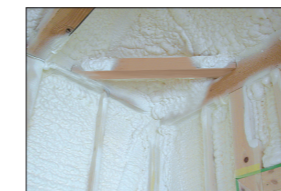
熱橋金物部分
