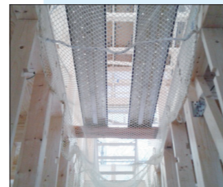
階段室などの床開口落下防止
