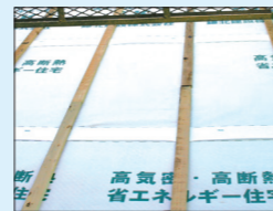
透湿防水シートの施工
