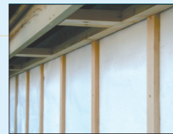
透湿防水シートの施工
